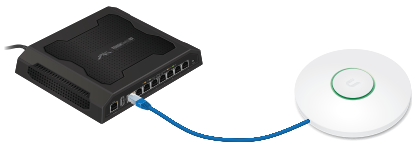
Punto de acceso UniFi conectado a TOUGHSwitch PRO
